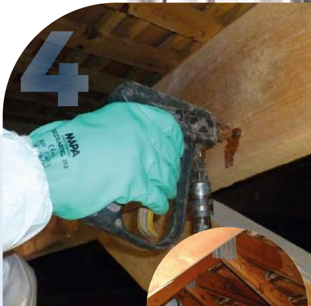
Injection sous pression jusqu'à suintement
