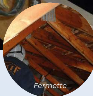
Injection sous pression jusqu'à suintement
