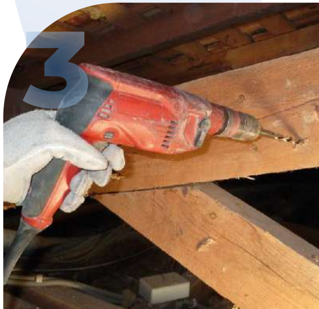
Perçage des puits d'injection
