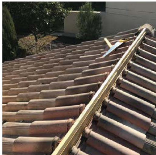
Dépose de couverture
