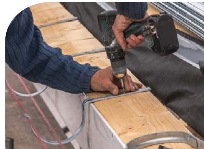
Mise en place des crochets Mise en place des demi-rondes Soudures
